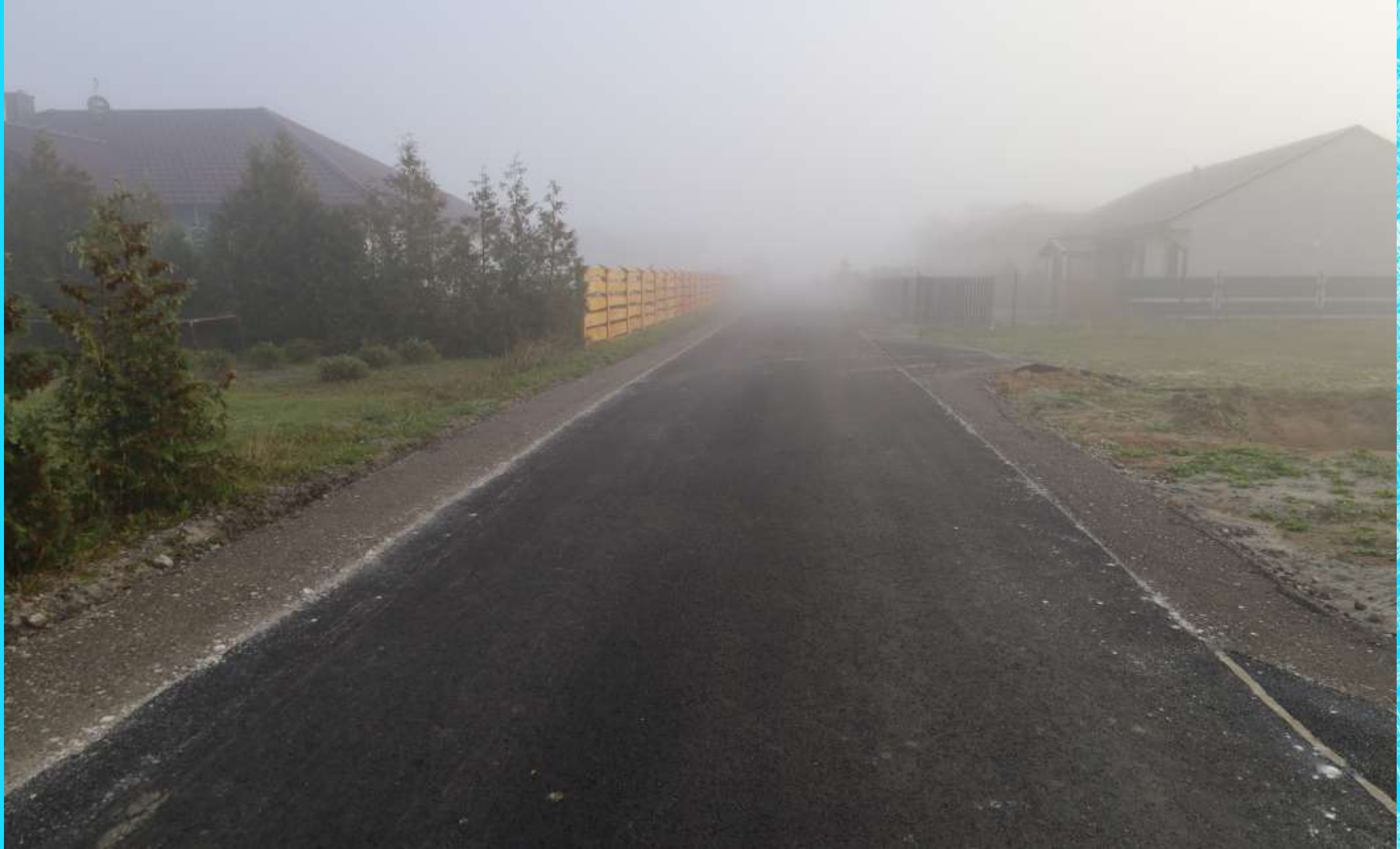
ul. Zagonowa w Pigży
