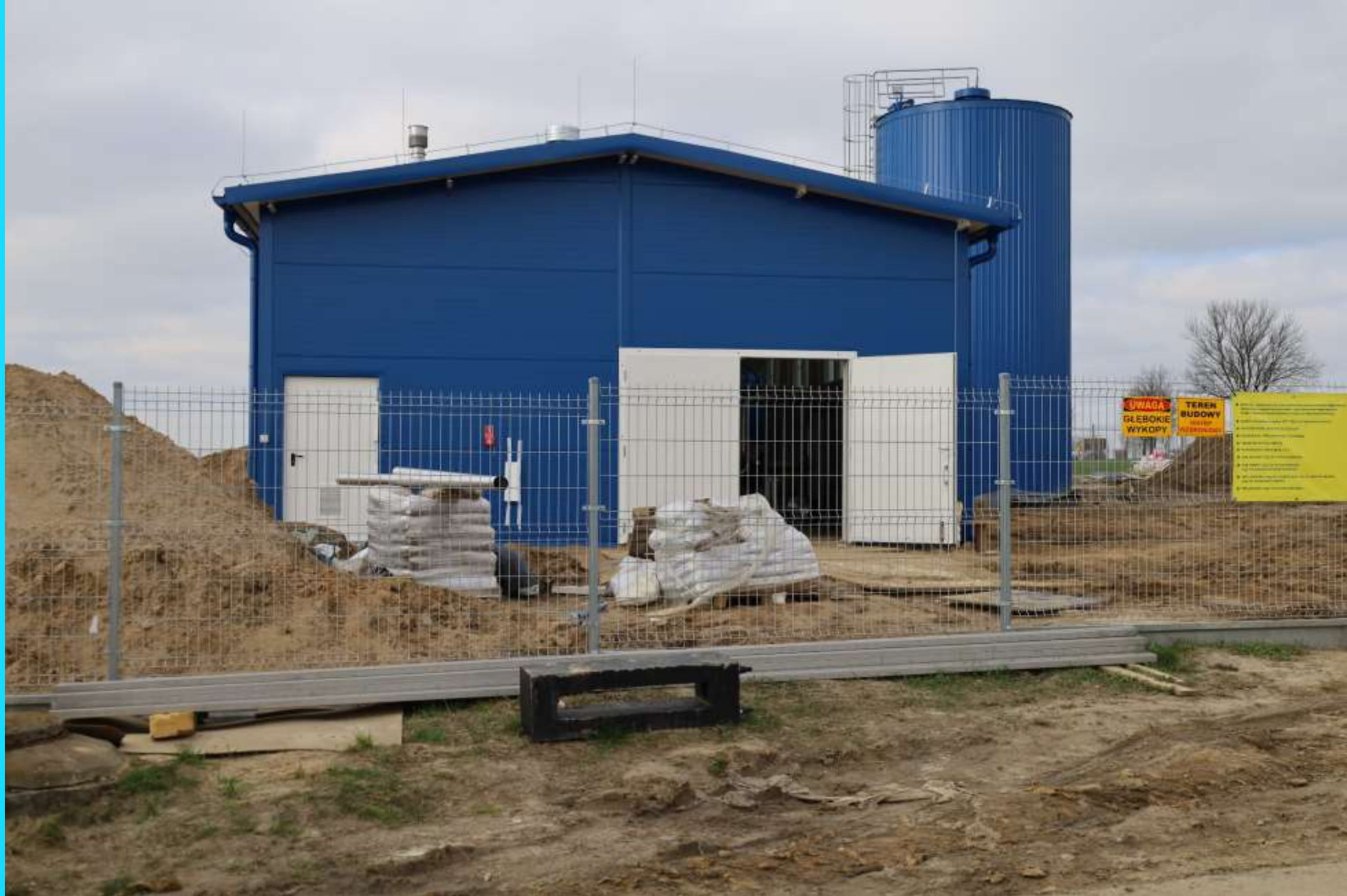
Stacja Uzdatniania Wody w Przecznie w budowie
